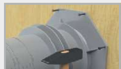
Fixare prin flanșă de nivelare
