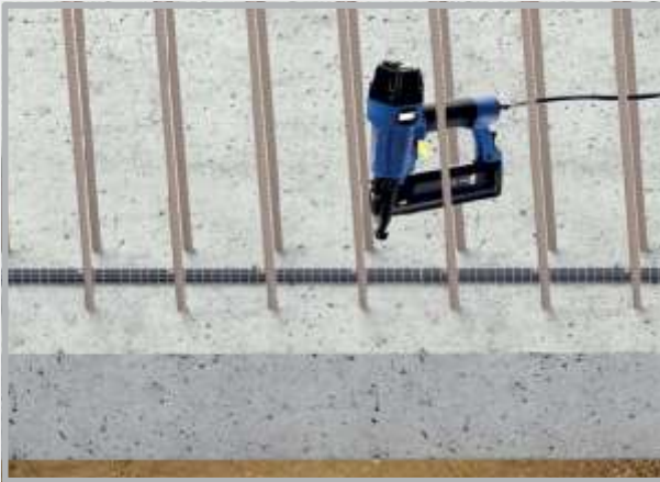
Instalare cu grilă de fixare și cuie
