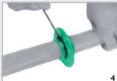
Strângeți manual cele două benzi de tensionare
