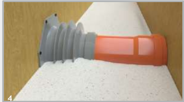
4 Betonare și vibrare atentă
