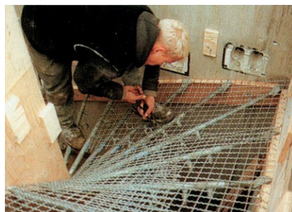
Grilele flexibile ondulate sunt așezate pe tuburile telescopice și fixate cu sârmă de legătură
