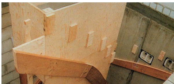
Apoi se montează și se fixează „ochiul interior”
