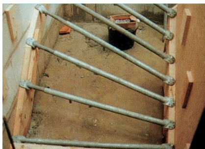
Tijele telescopice sunt instalate de jos în sus
