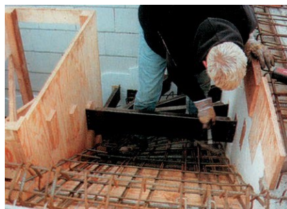
Cofrajul reglabil pentru trepte este fixat pe pliurile treptelor cu cuie de 65 mm.
