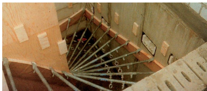
Tijele telescopice sunt atasate de lateralele din lemn la o distanță de aprox. 30 cm folosind știfturi de carton de 35 mm
