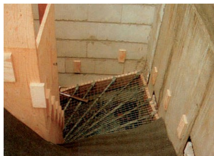
Învelișul scărilor este plasat pe grila ondulantă și tăiat pentru a se potrivi. Este atașat de barele telescopice folosind sârmă de legătură
