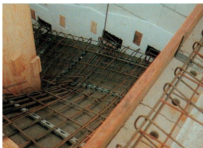
Armătura sau fierul este așezat și fixat cu distanțiere corespunzătoare (42 metri liniari de fier rotund de 8 mm și aproximativ 8 m 2 armătură Q 131)
