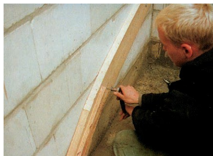
Fixează grinzile sau fețele cu dibluri de 8 x 80 mm pe perete
